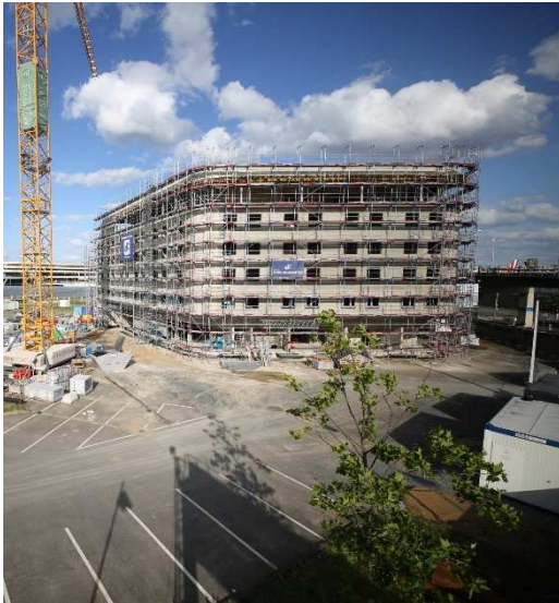
Fertigstellung Rohbau Moxy Köln Bonn Airport Bildquelle / Nutzungsrechte: Art-Invest Real Estate
